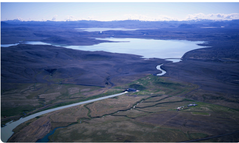
Hrauneyjafossvirkjun og Sigölduvirkjun (fjær) nýta jökulvatn úr Þórisvatni og Tungnaá. Samanlagt uppsett afl þeirra er 360 MW sem er nærri helmingur þess sem stærsta vatnsaflsvirkjun landsins, Fljótsdalsvirkjun, framleiðir.
