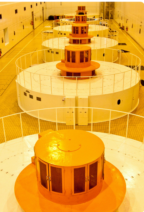
Búrfellsvirkjun í Þjórsá hóf að framleiða rafmagn árið 1969. Í Búrfellsstöð eru nú sex rafalar, en uppsett afl þeirra er samtals 270 MW. Fyrir dyrum stendur að byggja nýja aflstöð við hlið þeirra gömlu.
