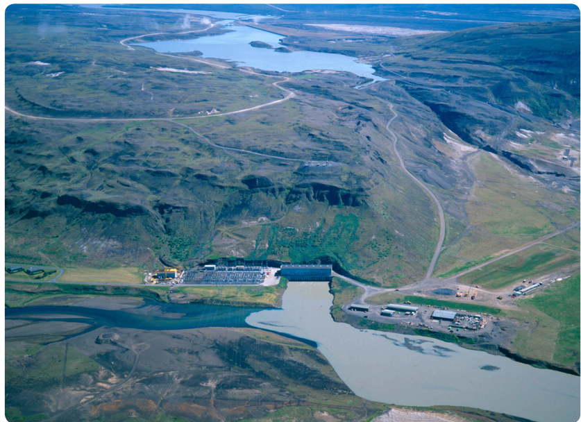
Búrfellsvirkjun í Þjórsá hóf að framleiða rafmagn árið 1969. Í Búrfellsstöð eru nú sex rafalar, en uppsett afl þeirra er samtals 270 MW. Fyrir dyrum stendur að byggja nýja aflstöð við hlið þeirra gömlu.
